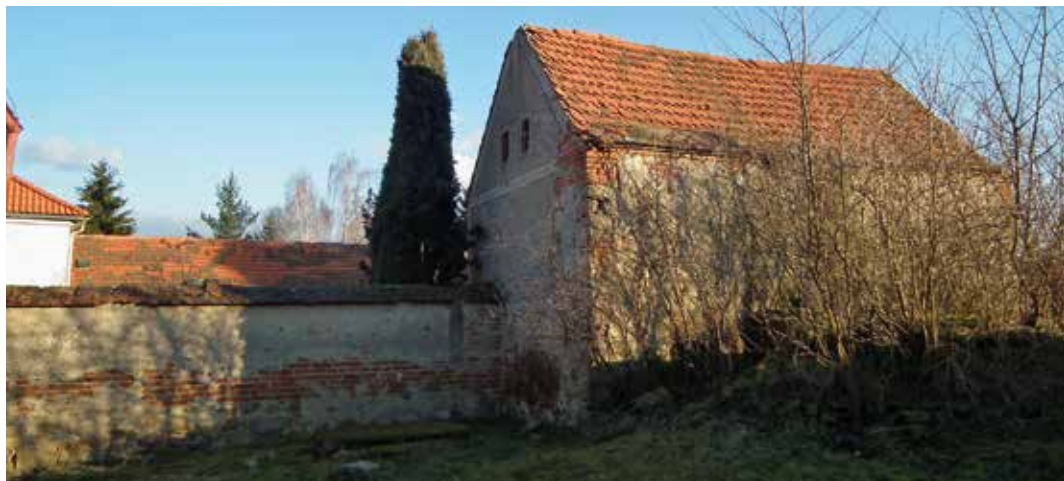
Dochovaná západní zeď prostibořské synagogy s přistavěnou kůlnou (pohled od západu), foto V. F. Chvátal.
