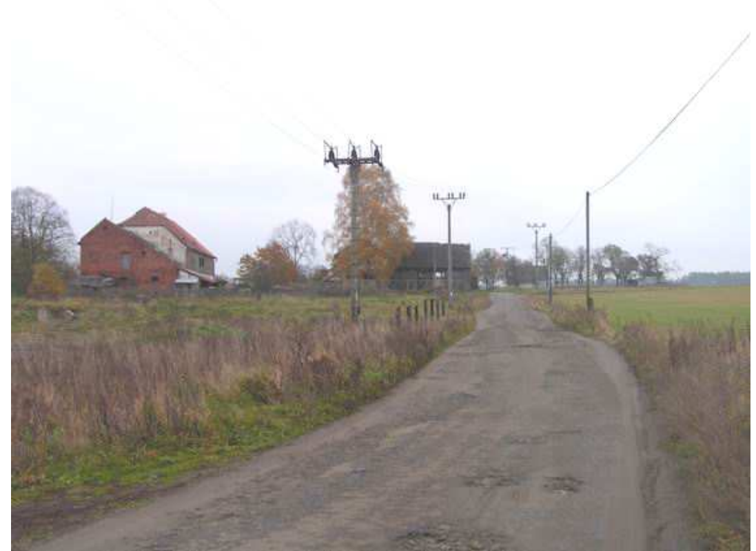
Obr. 5.40: Veselí - rozptýlená zástavba (množství přestaveb).
