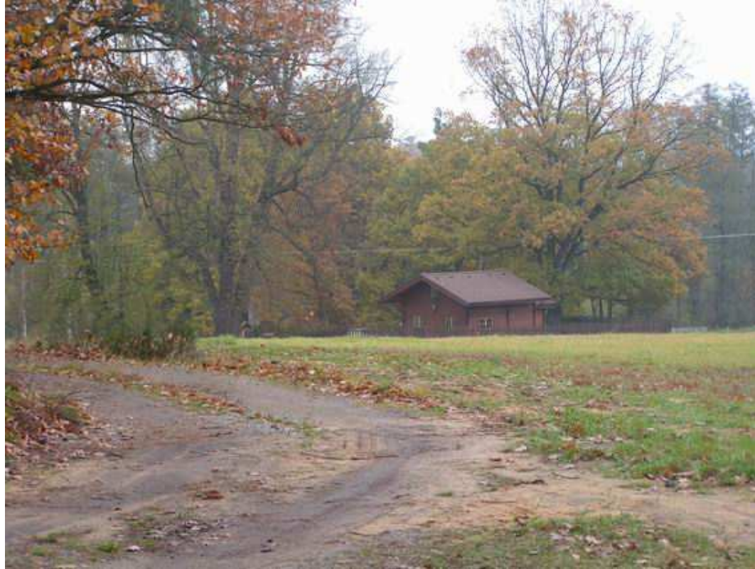
Obr. 5.39: Veselí - stávající jednopodlažní objekt chaty.
