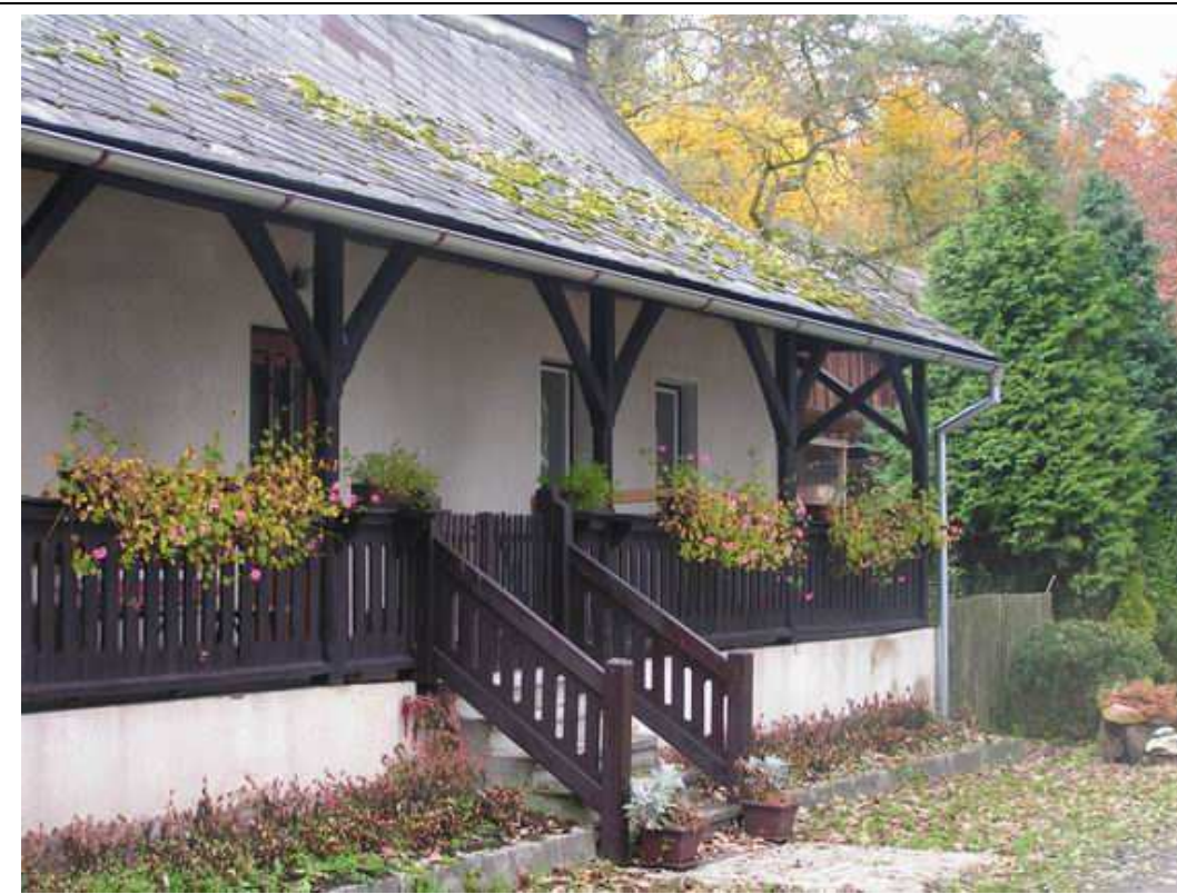
Obr. 5.12: Břehyně - osamocený objekt na hrázi Břehyňského rybníka - detail. (Foto: Atelier V)
