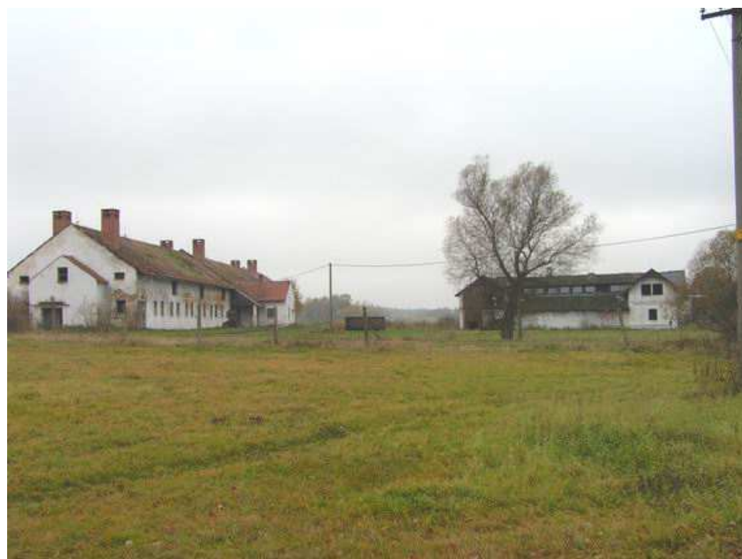
Obr. 5.27: Heřmaničky - polorozpadlý zemědělský areál na okraji osady.
