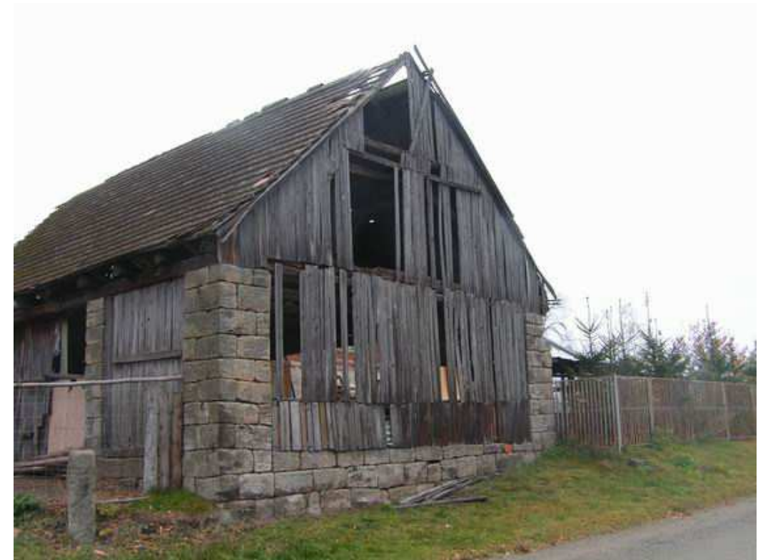
Obr. 5.42: Veselí - stávající objekt.
