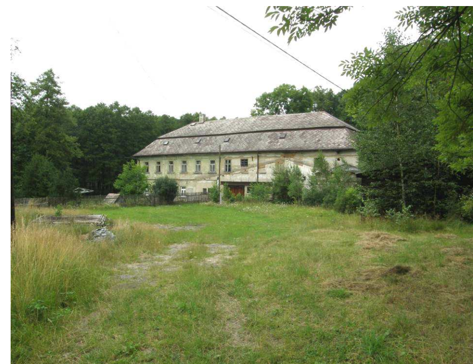
Obr. 121: Bývalý mlýn v Břehyni (Foto: Atelier V)
