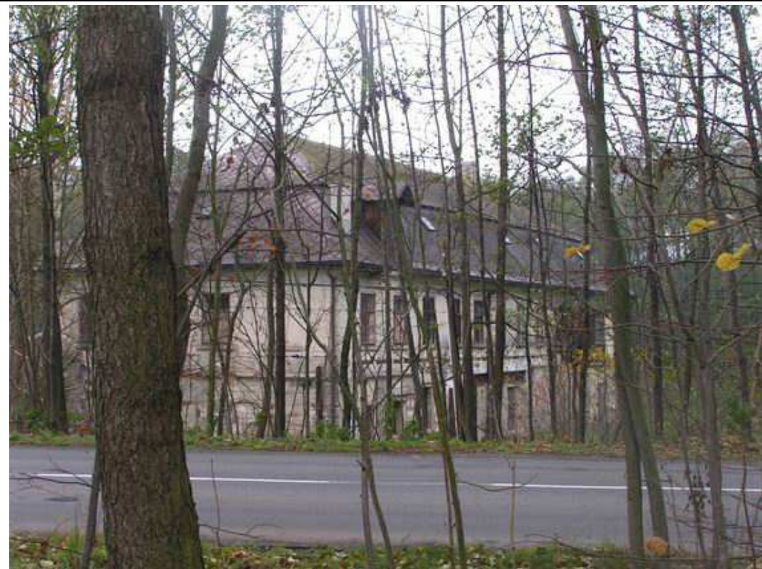
Obr. 5.7: Břehyně - klasicistní budova bývalého mlýna (vodní pily). (Foto: Atelier V)
