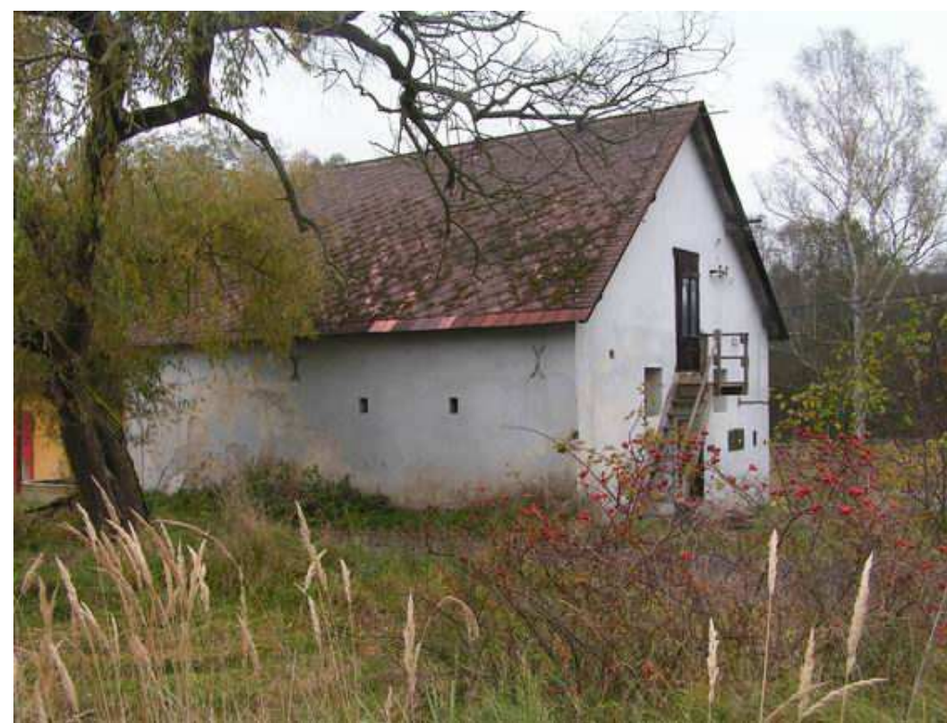
Obr. 5.10: Břehyně - stávající objekt. (Foto: Atelier V)
